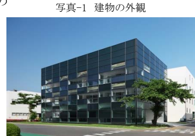
写真-1 建物の外観
