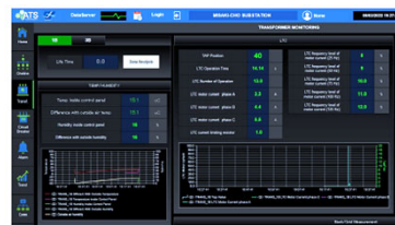
変圧器設備診断画面
